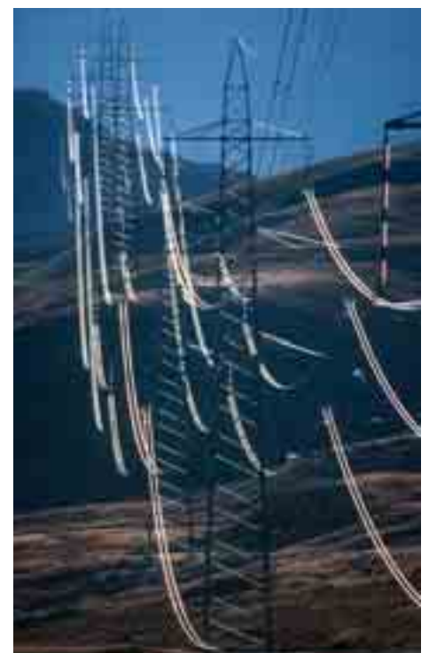
Linea aerea di 220 kV nei pressi di Laax GR.
